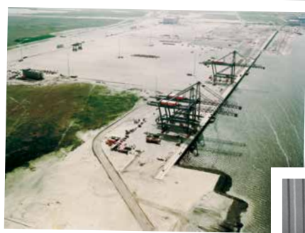
1982 Bouw Delta terminal.
